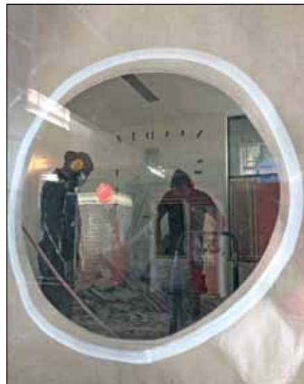
Ins Packpapier geschnittene Gucklöcher lassen einen neugierigen Blick auf das Geschehen im Gebäude zu. (pw)
