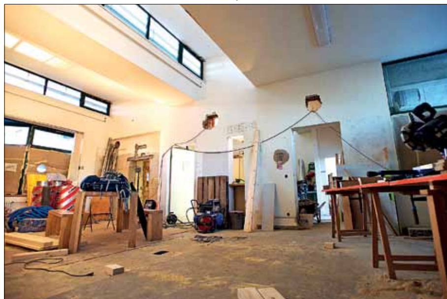
Die ehemalige Schalterhalle ist im Wandel. Hier lässt sich künftig Kaffee trinken, Mittagessen oder eine Abendveranstaltung besuchen. (zvg)
