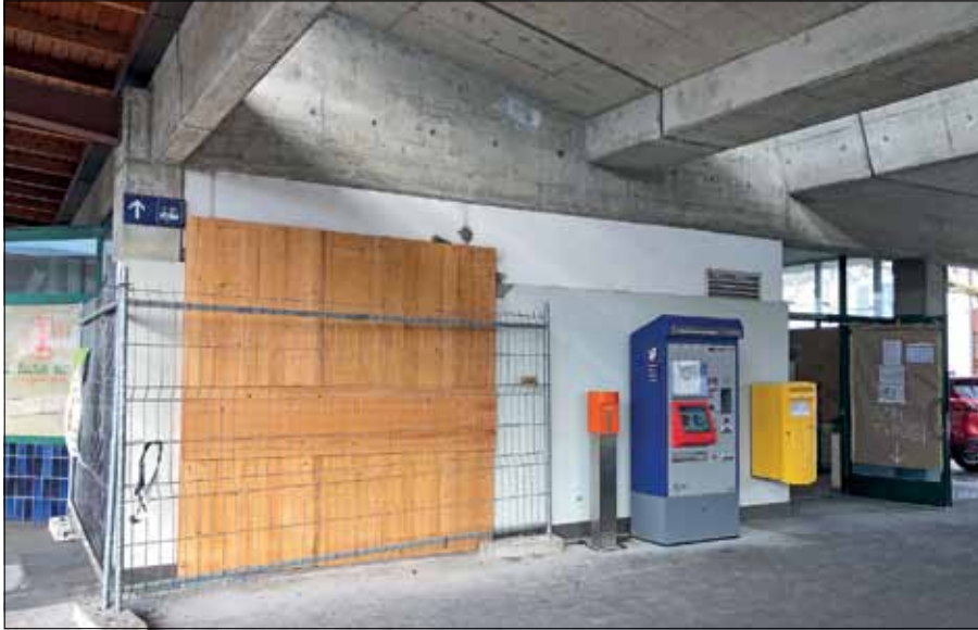
Seit Januar 2017 ist der ehemalige Schalter der SBB geschlossen. Seither standen die Räumlichkeiten leer. Seit ein paar Monaten ist wieder Leben im Haus. (pw)
